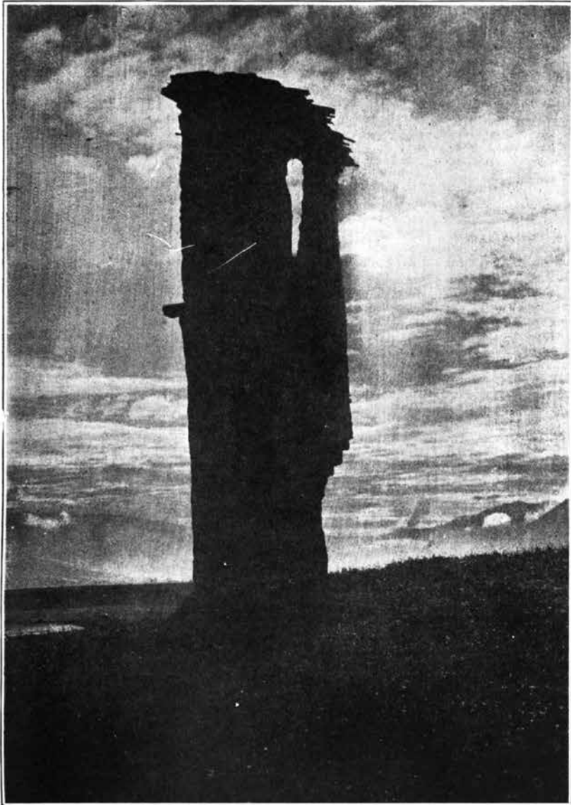
CAMPANARIO DERRUIDO. —La torre solitaria que se alza en Koripata, muy cerca del emplazamiento del barrio inkaiko de Pumakchupan en el Cuzco. — (Foto: Chambi.)
