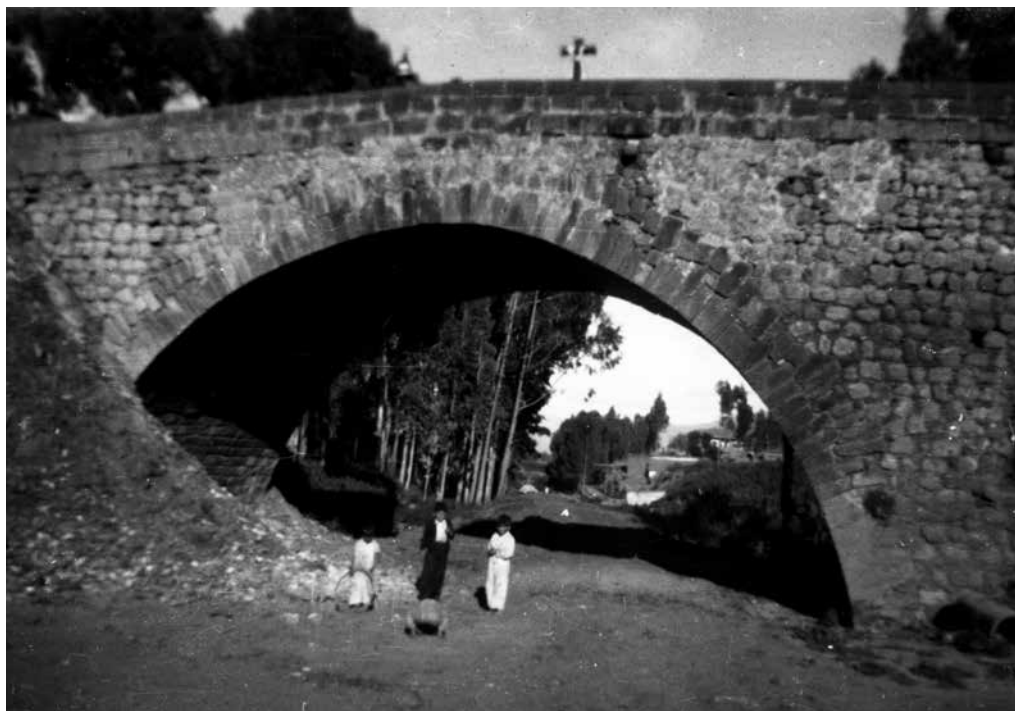
Puente de Belén, antes del terremoto de 1950.
